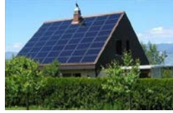
1 MW Üretim Tesisi
